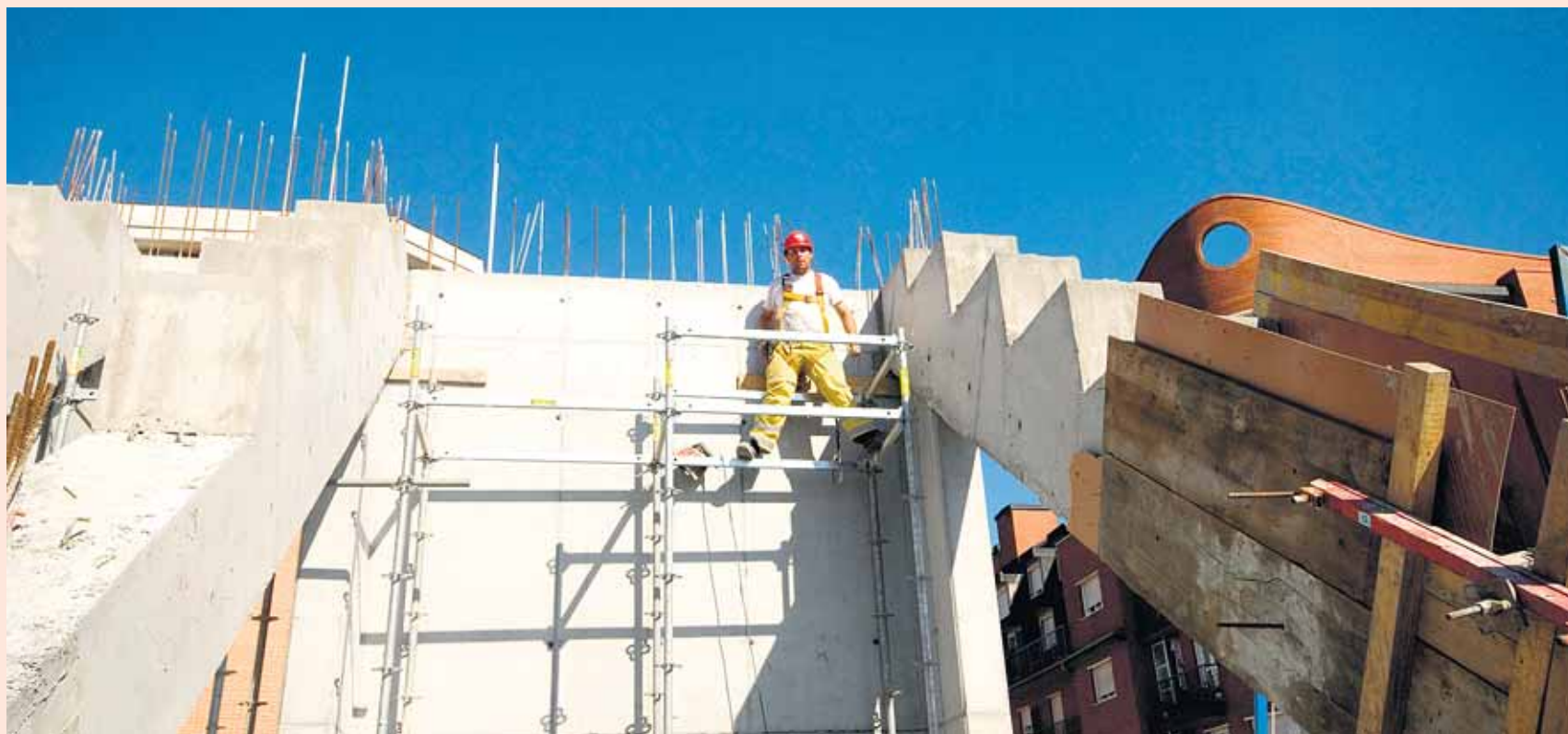
En 2012 ningún operario sin formación específica podrá realizar trabajos en altura.
